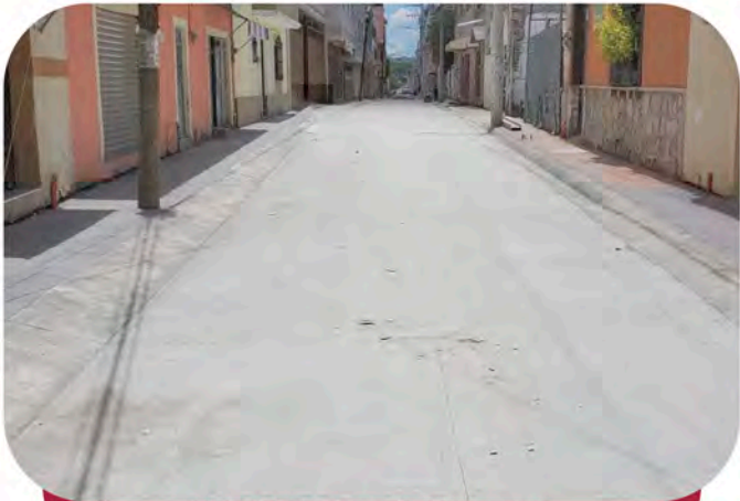
Rehabilitación calle Primavera Colonia Centro.
