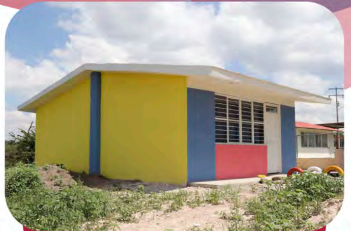
Construcción aula y baños para Jardín de Niños en la Comunidad el Húmedo.
