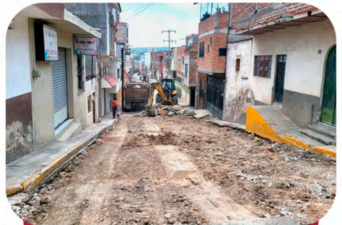
Rehabilitación calle Independencia Colonia Centro.
