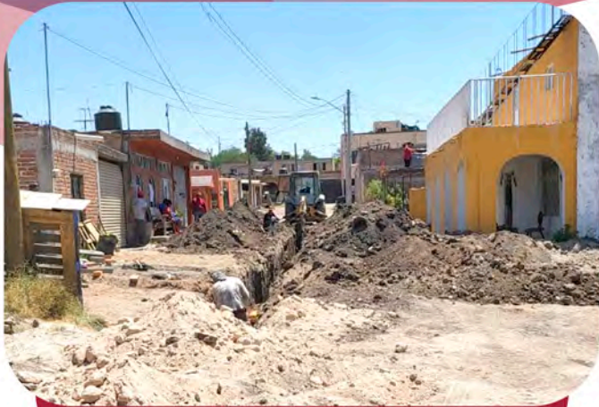
Rehabilitación calle Juan Sánchez Delegación Mezquitic.
