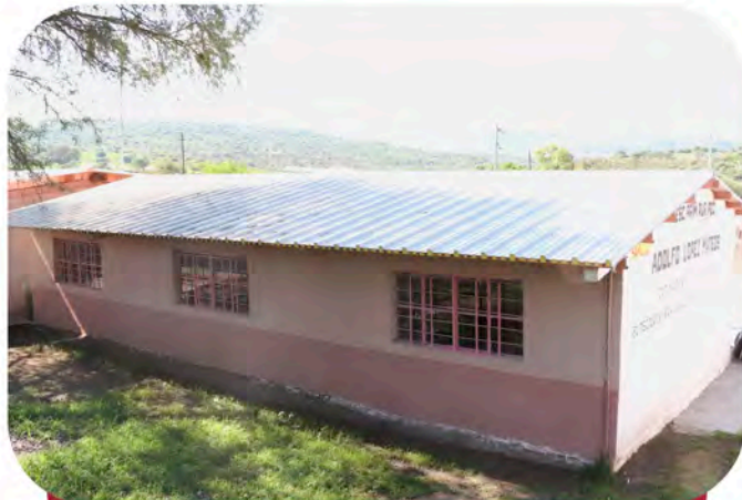
Rehabilitación de techo de 3 aulas Prim. Adolfo López Mateos, Com. el Tecolote.
