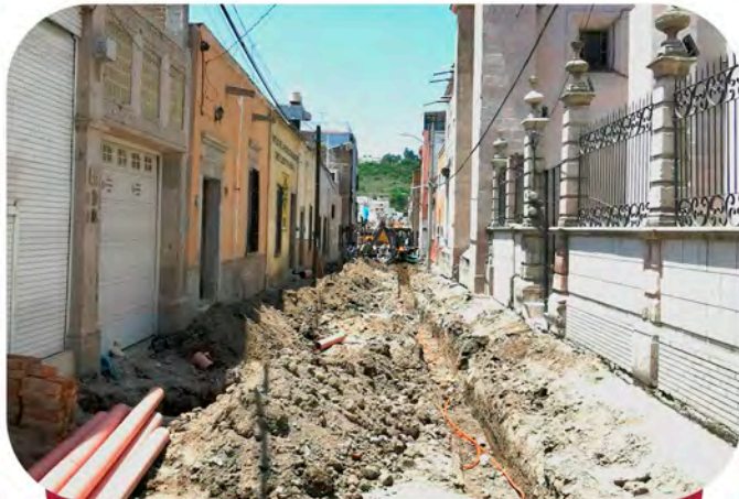
Rehabilitación de calle Minerva Colonia Centro.
