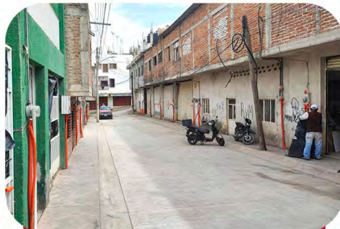
Rehabilitación calle Simón Bolívar Colonia Centro.
