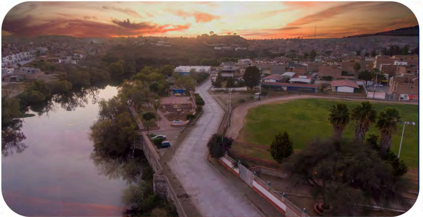
Rehabilitación calle Prolongación Pedro Galeana Colonia el Rosario.
