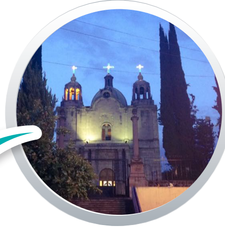
PARROQUIA DE LA SANGRE DE CRISTO CONSTRUCCIÓN SIGLO XIX
