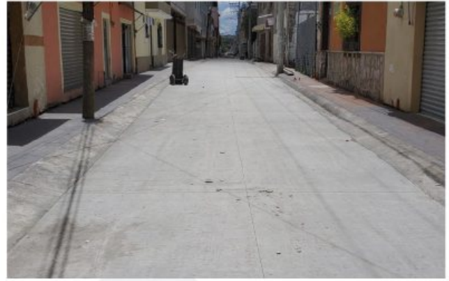
PAVIMENTACIÓN DE CALLE PRIMAVERA 1ERA ETAPA
