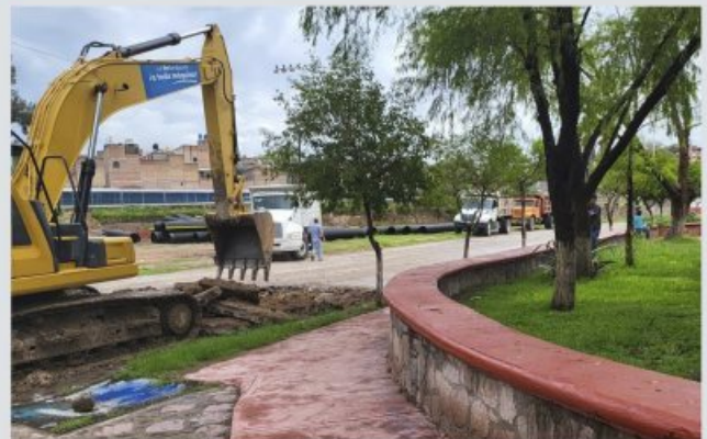
REHABILITACIÓN DE CALLE PROL. PEDRO GALEANA COL. EL ROSARIO
