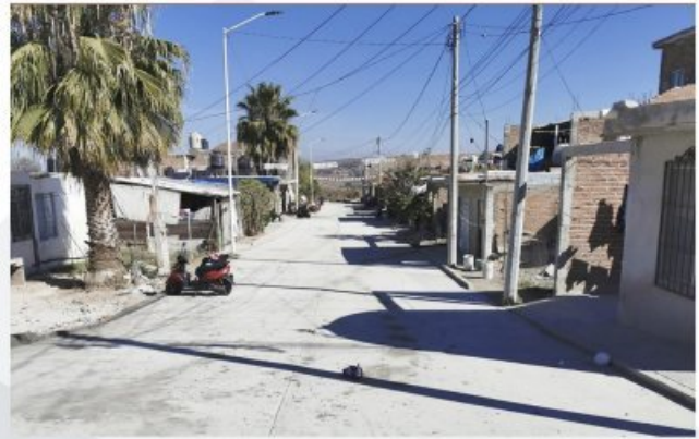
PAVIMENTACIÓN DE CALLE AZAFRANES COL. LOMAS VERDES
