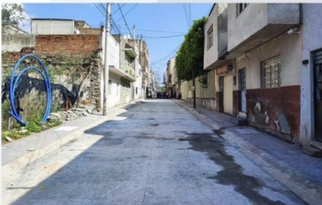
PAVIMENTACIÓN DE CALLE PRIMAVERA 2DA ETAPA
