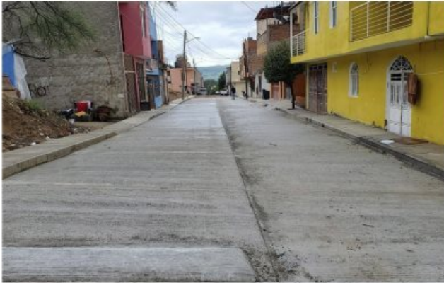
PAVIMENTACIÓN DE CALLE AGUSTÍN YAÑEZ 2DA ETAPA
