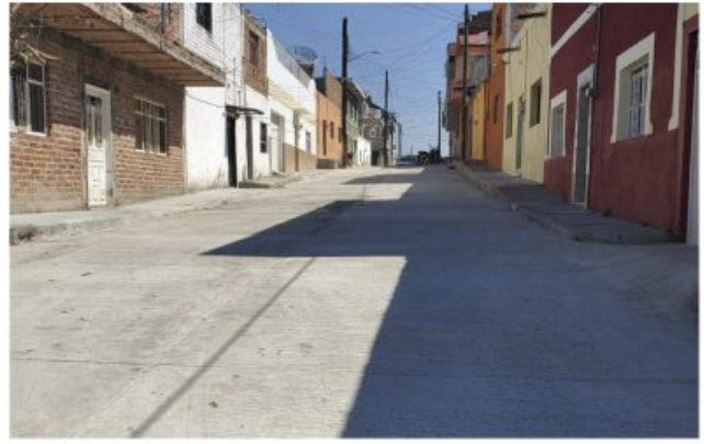
PAVIMENTACIÓN DE CALLE JAVIER MINA COL. LEONÍSTICA
