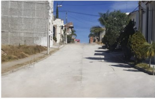
PAVIMENTACIÓN DE CALLE JUAN PABLO II COL. EL ROSARIO
