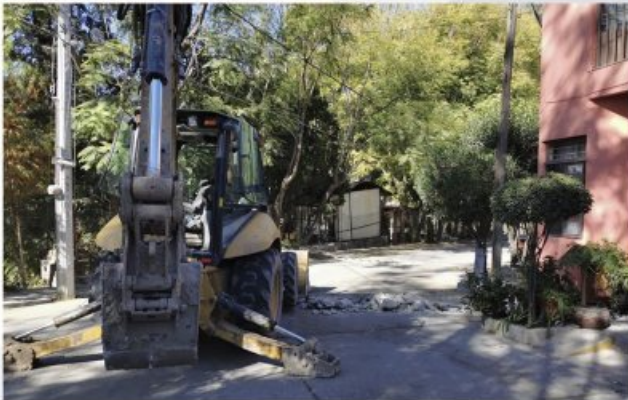
PAVIMENTACIÓN DE CALLE BERNARDO ZEPEDA COL. ESPÍRITU SANTO
