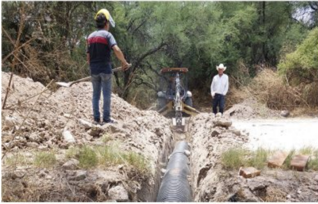
COLOCACIÓN DE VADO PASO DE TRUJILLOS
