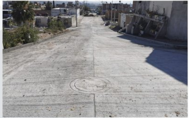
PAVIMENTACIÓN DE CALLE ORQUÍDEAS COL. LOMAS VERDES
