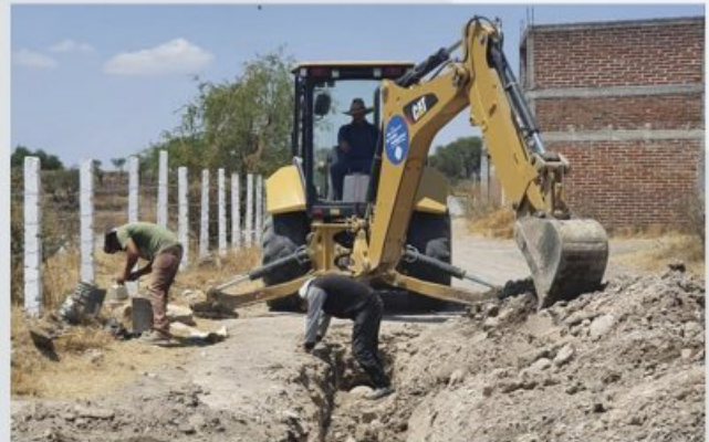
COLOCACIÓN DE DRENAJE COLONIA ROSA DE CASTILLA
