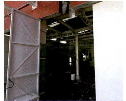
Puertas de ingreso a la sala de sacrificio. Esta remodelación evita el ingreso de fauna nociva y personal no autorizado
