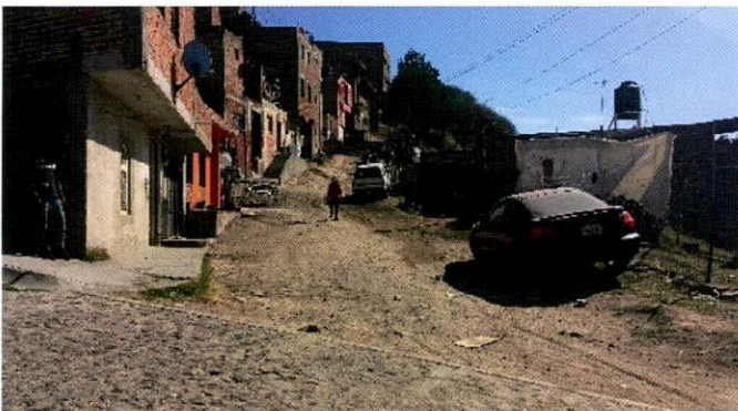
Calle: El Plan Colonia: Las Antenas Volumen de obra: 1,992 m 2
