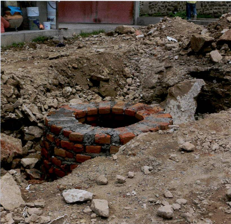
Pavimentación de Calle Gardenias, Col. Las Lllamaradas
