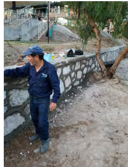
Muro de contención en la Escuela Primaria Pedro Ogazón
