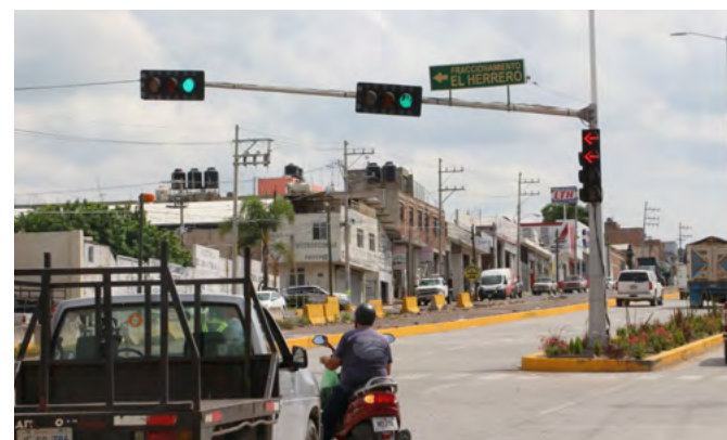
Mantenimiento de semaforización.
